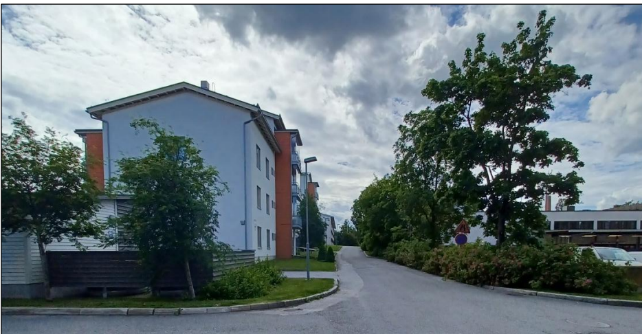
Kuva 3. Näkymä Mäntykadun varren kerrostaloihin. 18.6.2026
