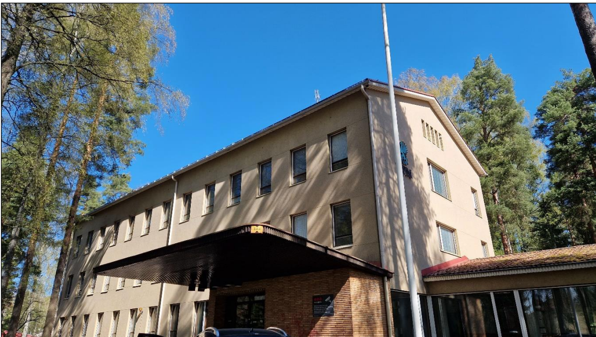
Kuva 1: Pääkonttorin korkeampi rakennusosa. Rakennusinventointi, Insinööritoimisto Lepistö 2023
