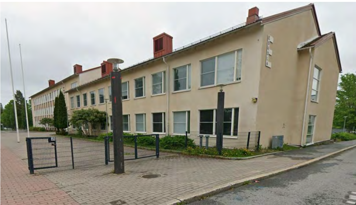
Kuva 1. Kuva olevasta rakennuksesta Oikokadulta kuvattuna. Google maps 2025.
