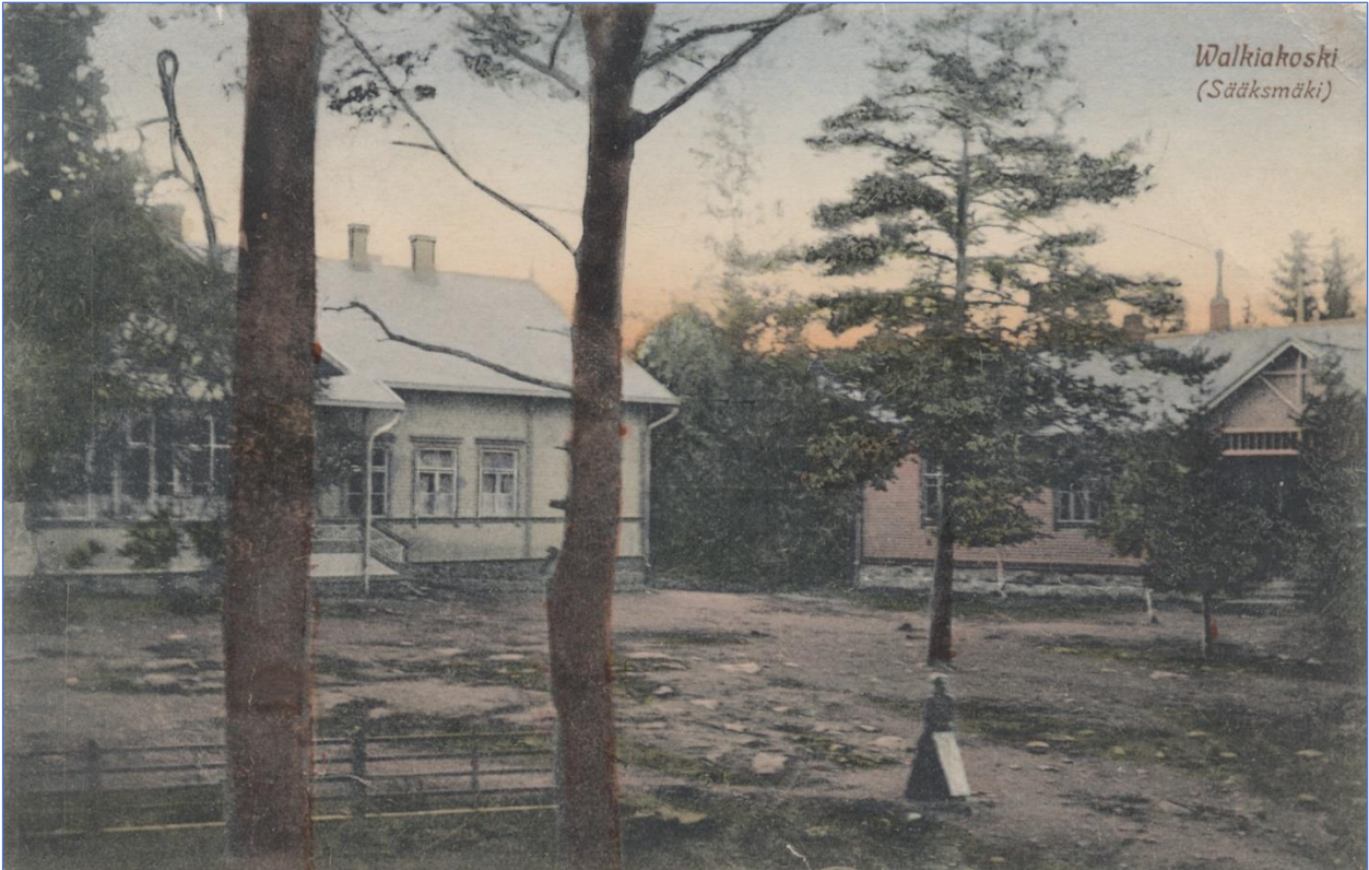
Koulurakennukset ennen laajennusta, etualalla kivimuurin päällä sijaitseva kaide (A. Sirén, UPM Kymmene Oyj)
