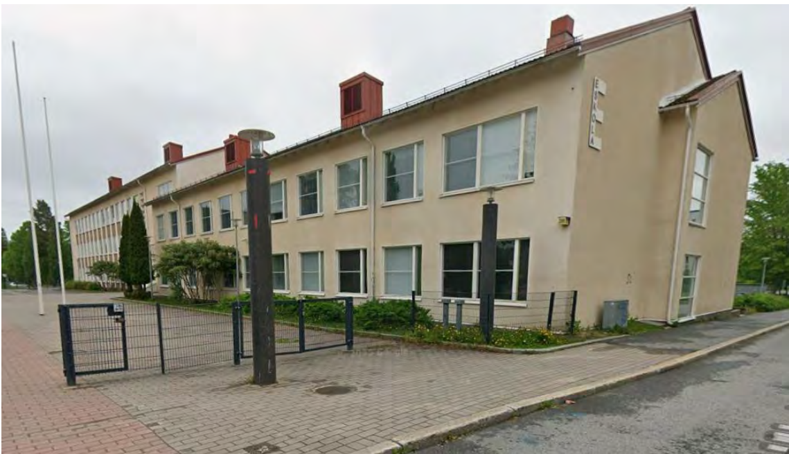
Kuva 1. Kuva olevasta rakennuksesta Oikokadulta kuvattuna. Google maps 2025.
