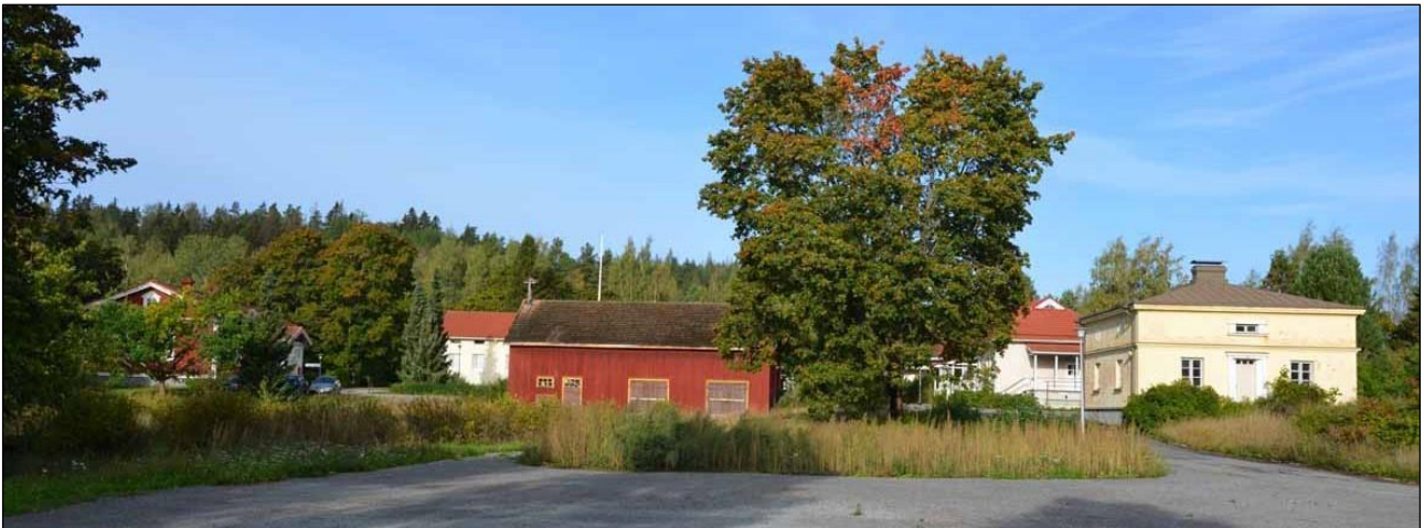
Kuva 6. Kemmolan pihapiirin rakennuksia. Sääksmäen vanhainkoti, rakennusinventointi 2019, Kulttuuriympäristöpalvelut Heiskanen & Luoto Oy
