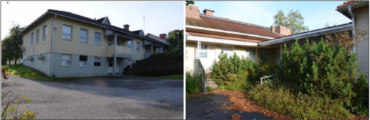
Kuva 14. Vanhainkodin 1980-luvulla rakennettu nivelosa. Sääksmäen vanhainkoti, rakennusinventointi 2019, Kulttuuriympäristöpalvelut Heiskanen & Luoto Oy
