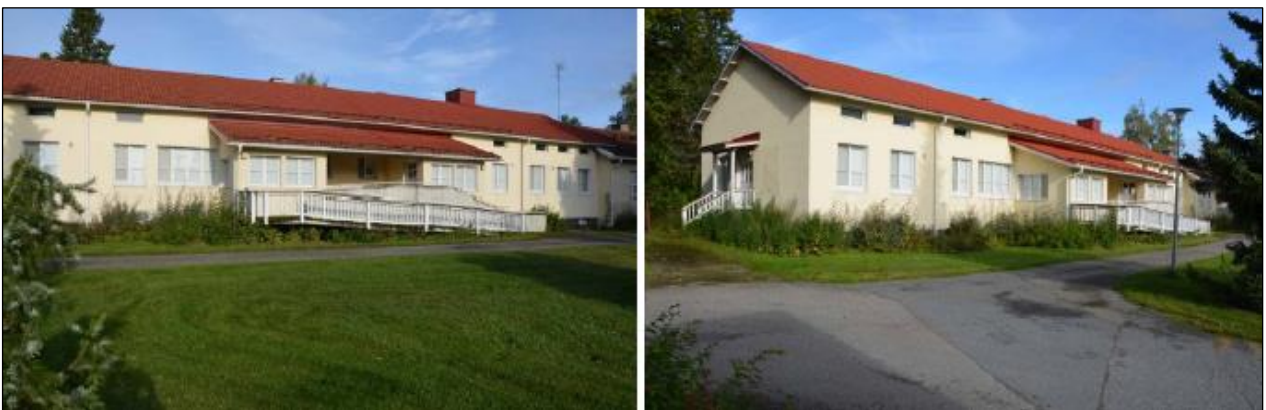
Kuva 13. Vanhainkodin 1950-luvulla rakennettu osa. Sääksmäen vanhainkoti, rakennusinventointi 2019, Kulttuuriympäristöpalvelut Heiskanen & Luoto Oy
