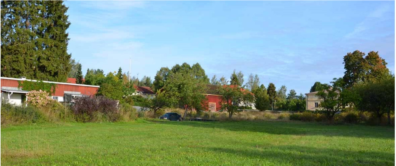
Rakennusten muodostama kokonaisuus näkyy lähinnä eteläpuolelta, Kemmolan omakotialueen kevyen liikenteen väylältä. Etualalla vanhaa peltoa.
