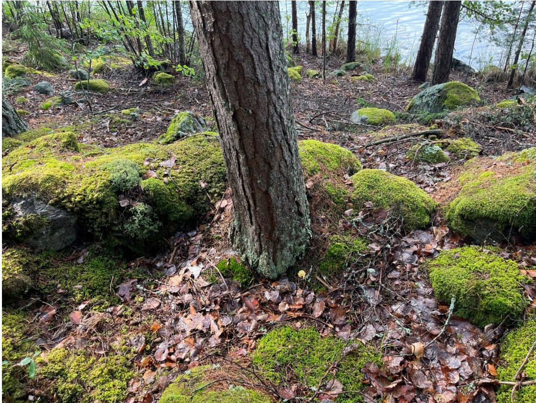
Kuva 28. Mänty on osittain tuhonnut rakenteen länsiseinämää.
