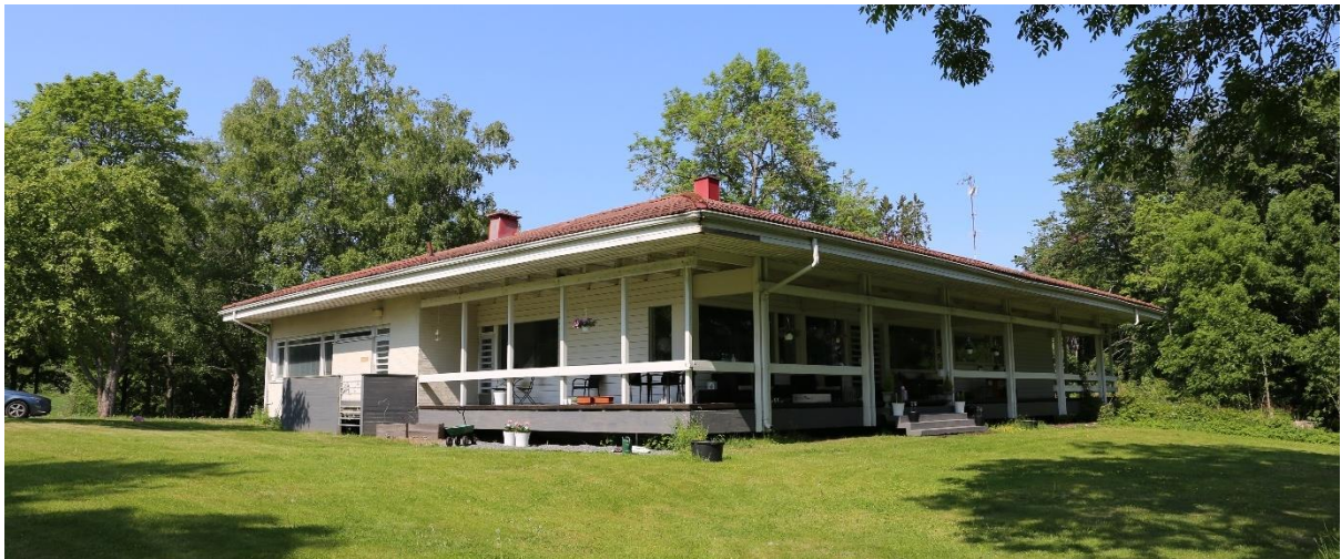
Päärakennuksen rannan puoleinen julkisivu.
