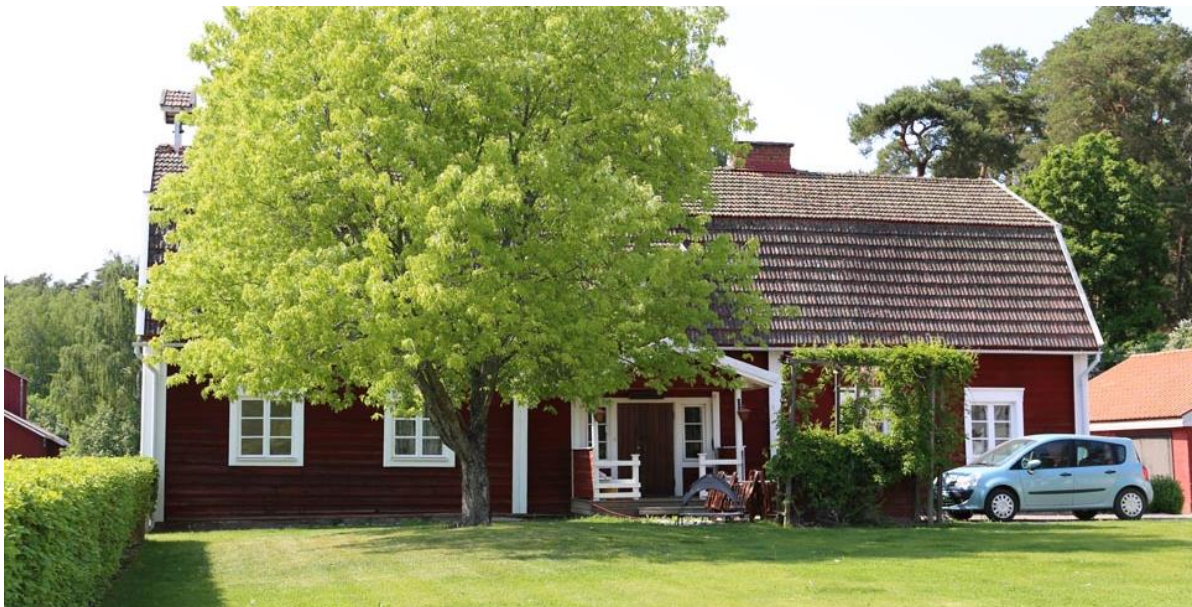
Päärakennuksen viereinen asuinrakennus.
