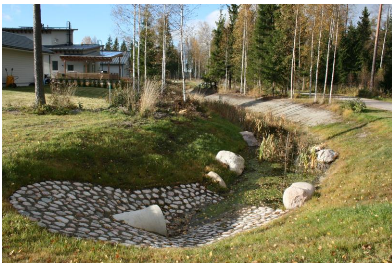
Kuva 12. Hulevesiä viivyttävä ja pidättävä oja (Vantaa, Renko 2015)
