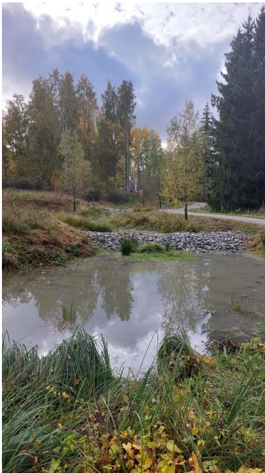
Kuva 14. Hulevesien viivytyksallas (Turku, Jaaninoja, Pääskyvuori 2022)
