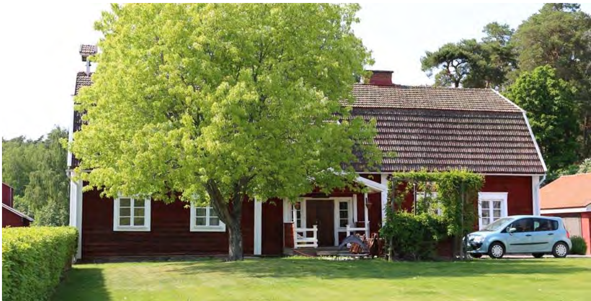
Päärakennuksen viereinen asuinrakennus.
