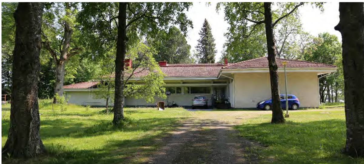
Päärakennuksen pihan puoleinen julkisivu.
