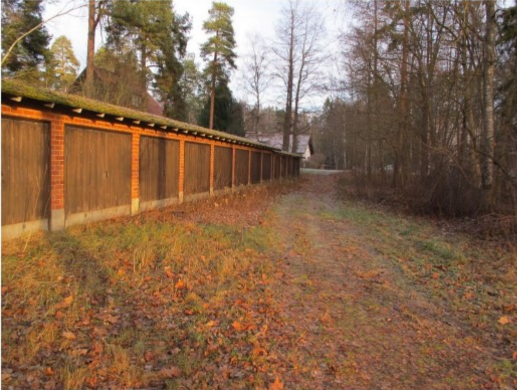
Kuva 2. Vanha autotallirakennus ja sen edustan ajoura. Valokuva © Marko Vauhkonen.
